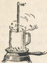
Fig. 36.—Termómetro sumergido en vapores de agua hirviendo.
